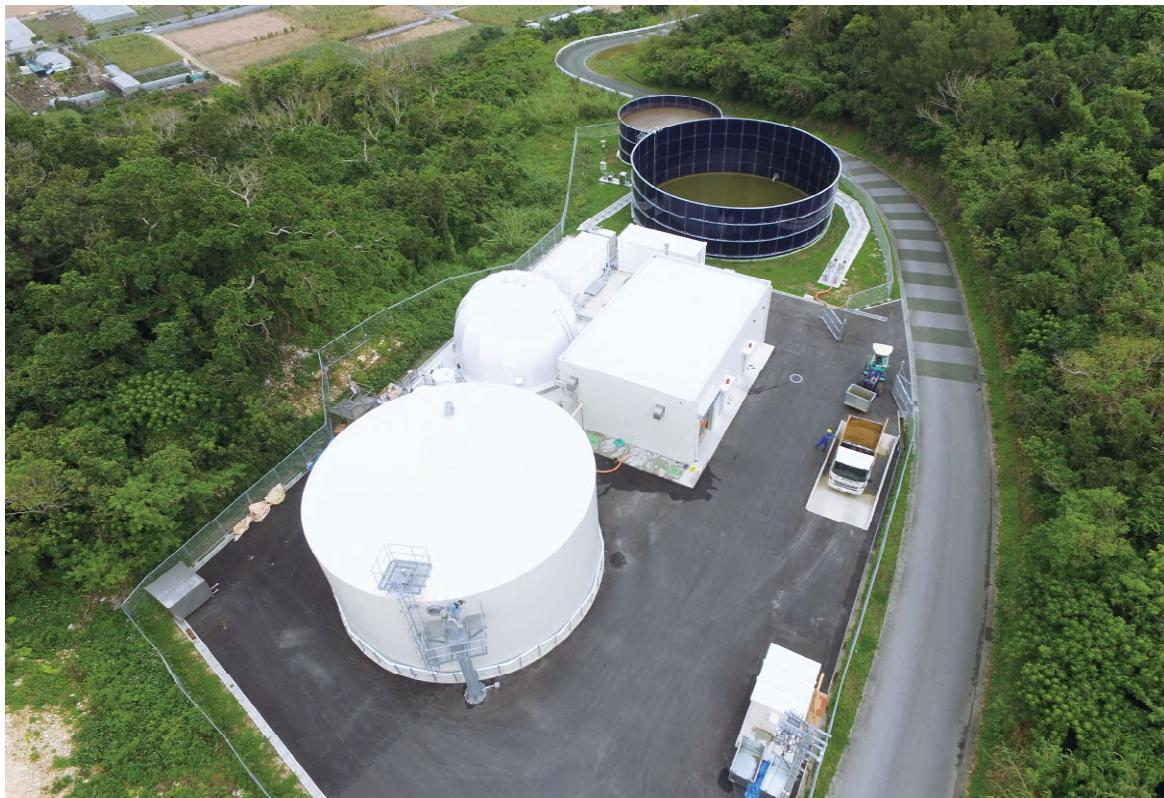
八重瀬町バイオガスプラントは、乳用牛ふん尿や食品残さ等の廃棄物を原料としたメタン発酵処理施設であり、(株)八重瀬堆肥センターが指定管理により運営しています。地域で発生した廃棄物からメタン発酵処理によってエネルギーを回収し、発電や熱利用をすることで地域資源の循環利用をしています。さらに、メタン発酵処理の副産物であるバイオ液肥を化学肥料の代替としてサトウキビや野菜等の農作物や牛のエサとなる牧草へ利用し、地域農業の発展に貢献しています。
